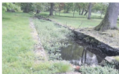
Tak źródłko wyglądało przed rozpoczęciem prac.
