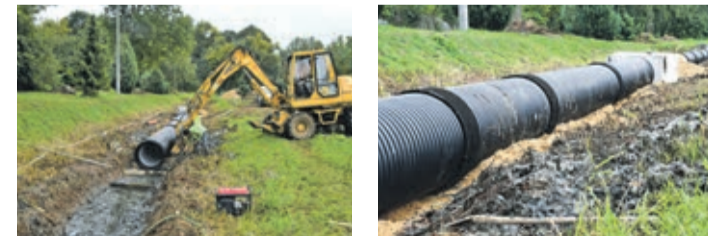
Tak wyglądała inwestycja w trakcie prac
