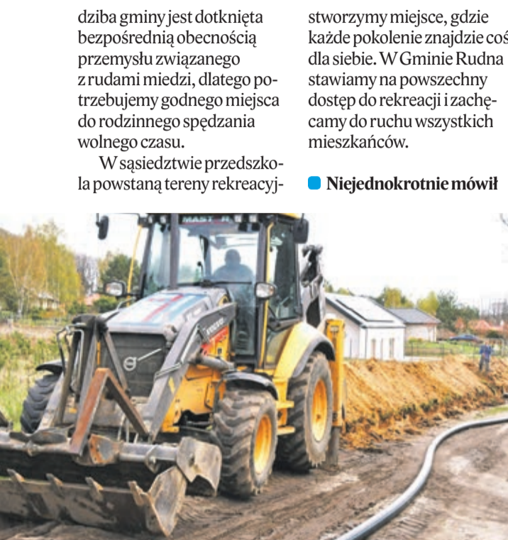
Tak wyglądają prace przy rozbudowie sieci wod-kan.
